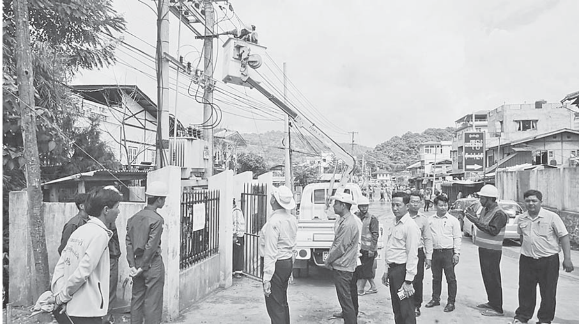
ရှမ်းပြည်နယ်(တောင်ပိုင်း) ကလေးမြို့နယ် သို့ရောက်ရှိရာ နမ့်ပန်တက်ဓာတ်အားခွဲ ရုံသို့ သွယ်တန်းထားသည့် ၃၃ ကေစီ ဓာတ်အားလိုင်းများ ရေတိုက်စားပြီးယိုင်လဲ ပျက်စီးခဲ့မှုနှင့် ပြန်လည်ပြုပြင်ဆောင်ရွက် နေမှုကို လိုက်လံကြည့်ရှုစစ်ဆေးခဲ့ပြီး ယခုဖြစ်စဉ်အား သင်ခန်းစာယူ၍ နောင်
