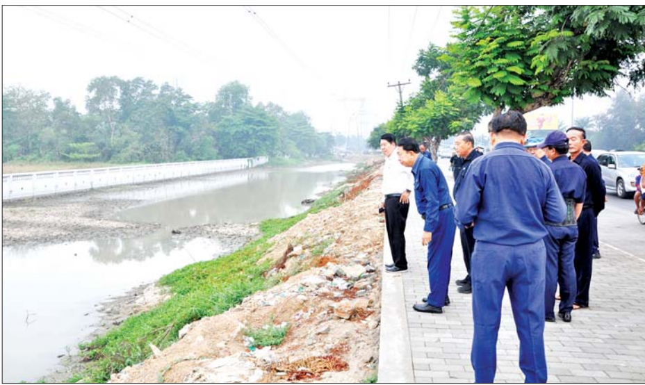
တွင် အင်ဂျင်နီယာဌာန (လမ်းနှင့် တံတား)က ဆောင်ရွက်နေသည့် ဘုရင့်နောင်တံတားအဆင်းမှ ပန်းလှိုင်အိမ်ရာဝင်း အဝင်လမ်းထိ ရန်ကုန်-ပုသိမ်ကားလမ်း ဘေးဝဲ/ယာ လူသွားစင်္ကြံဆောင်ရွက်ပြီးစီးမှုနှင့် ဆောင်ရွက်လျက်ရှိသည့် လုပ်ငန်းများ၊ ရန်ကုန်-ပုသိမ်ကားလမ်းနှင့် ကနောင်မင်းသားကြီးလမ်းထိပ်တွင် အကျယ် ၁၂ ပေ၊ အရှည်ပေ ၁၁၀ ရှိ Box Culvert ဆောင်ရွက်နေသည့်
