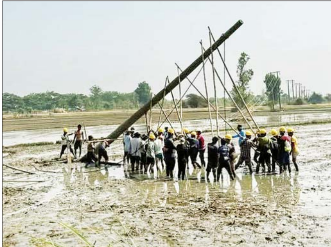
စက်ယန္တရားအကူအညီမပါဘဲ လူအင်အားဖြင့် အပင်ပန်းခံကာ လျှပ်စစ်ဓာတ်အားလိုင်းများ ပြုပြင်ပေးစဉ်။
