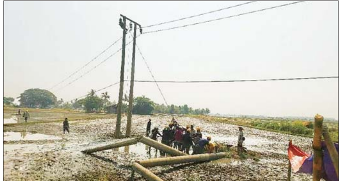
မန္တလေးမြေငလျင်ကြောင့် ပျက်စီးခဲ့ရသည့် လျှပ်စစ်ဓာတ်အားလိုင်းများ အမြန်ဆုံးပြန်လည်ကောင်းမွန်စေရန် လျှပ်စစ်လုပ်သားများ နေ့မအား ညမနား ဆောင်ရွက်စဉ်။
