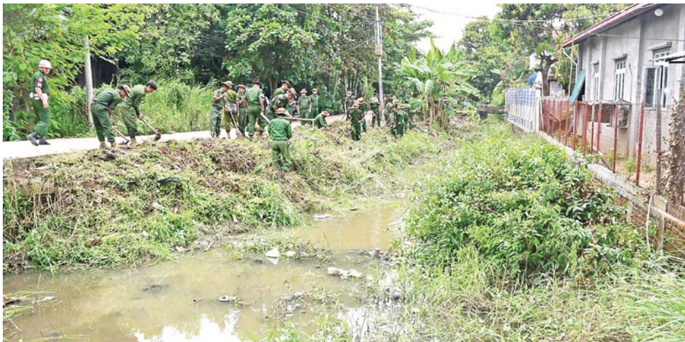
နယ်မြေခံတပ်မတော်သားများက ပဲခူးတိုင်းဒေသကြီး တောင်ငူမြို့ အမှတ်(၂) မင်းကြီးညိုရပ်ကွက် ပေါက်လှကြီးလမ်းရှိ ငနောက်ဆည်အတွင်း ရေစီးရေလာကောင်းမွန်စေရေးဆောင်ရွက်စဉ်။
