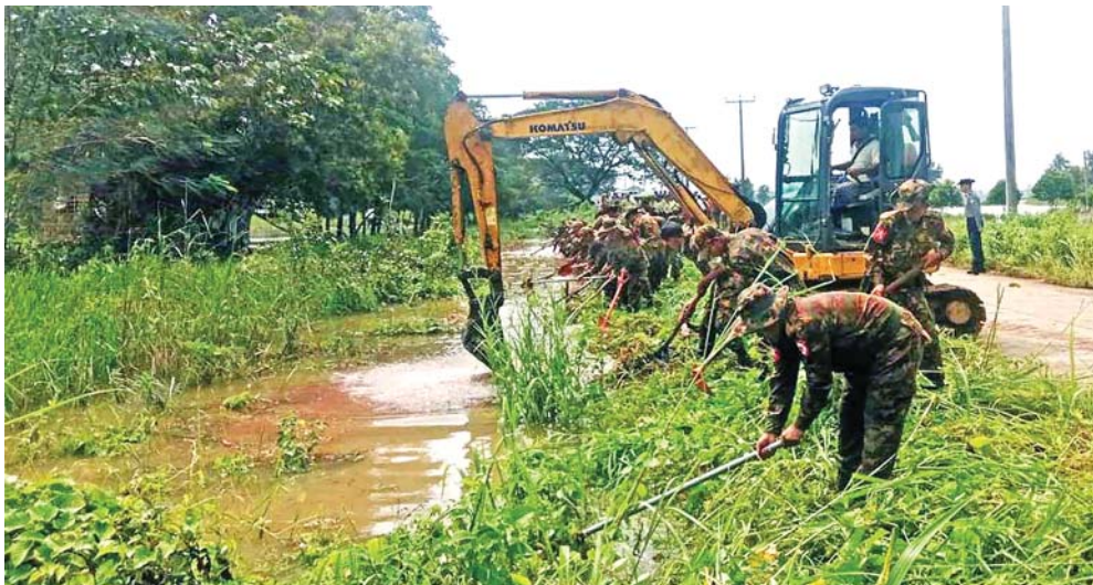
နယ်မြေခံတပ်မတော်သားများက ရန်ကုန်တိုင်းဒေသကြီး လှည်းကူးမြို့နယ် ဆီဆုံကုန်းကျေးရွာ လမ်းဘေးဝဲ/ယာတစ်လျှောက် ရေစီးရေလာကောင်းမွန်စေရေးဆောင်ရွက်စဉ်။
