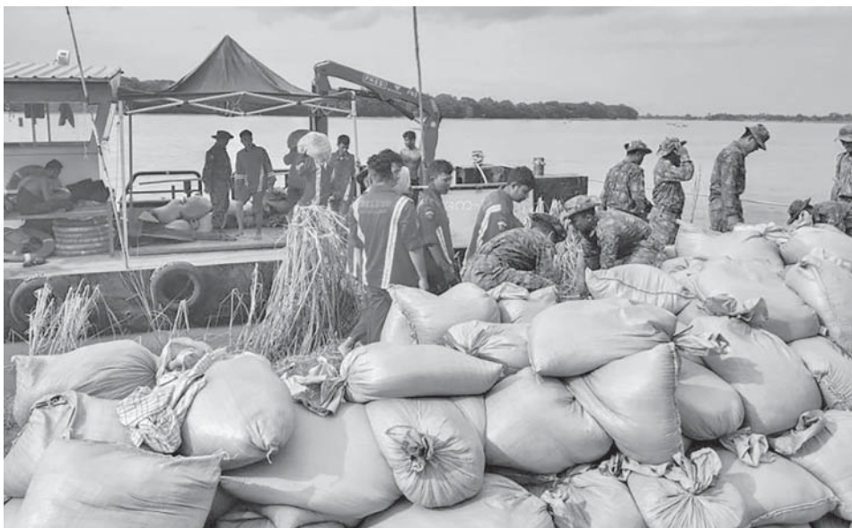
အနောက်တောင်တိုင်းစစ်ဌာနချုပ်မှ နယ်မြေခံတပ်မတော်သားများက မြစ်ရေတိုက်စားပြိုကျမှုမှကာကွယ်ရန် တာခြေထောက်ခြင်းအဖြစ် ကမ်းထိန်းအိတ်များချခြင်း၊ ရေရှိန်တားပြုလုပ်ခြင်း၊ ရေကာတာ တာပေါင်မြေဖို့ခြင်းလုပ်ငန်းများဆောင်ရွက်ပေးစဉ်။
