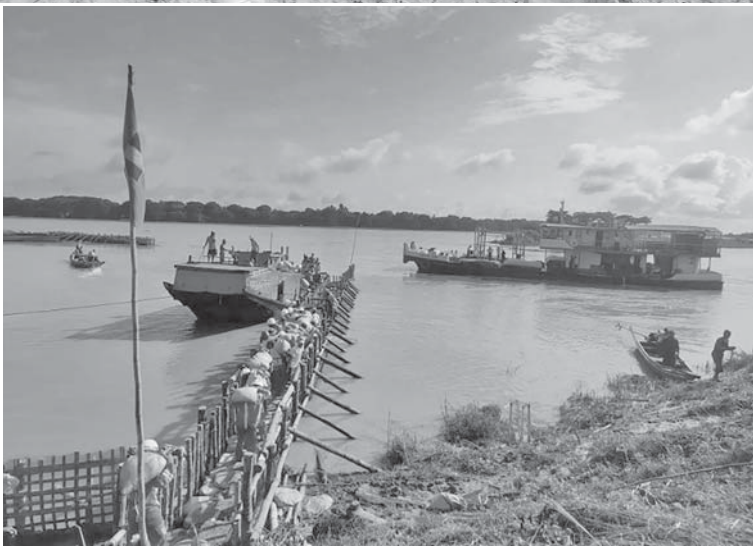
အနောက်တောင်တိုင်းစစ်ဌာနချုပ်မှ နယ်မြေခံတပ်မတော်သားများက မြစ်ရေတိုက်စားပြိုကျမှုမှကာကွယ်ရန် တာခြေထောက်ခြင်းအဖြစ် ကမ်းထိန်းအိတ်များချခြင်း၊ ရေရှိန်တားပြုလုပ်ခြင်း၊ ရေကာတာ တာပေါင်မြေဖို့ခြင်းလုပ်ငန်းများဆောင်ရွက်ပေးစဉ်။
