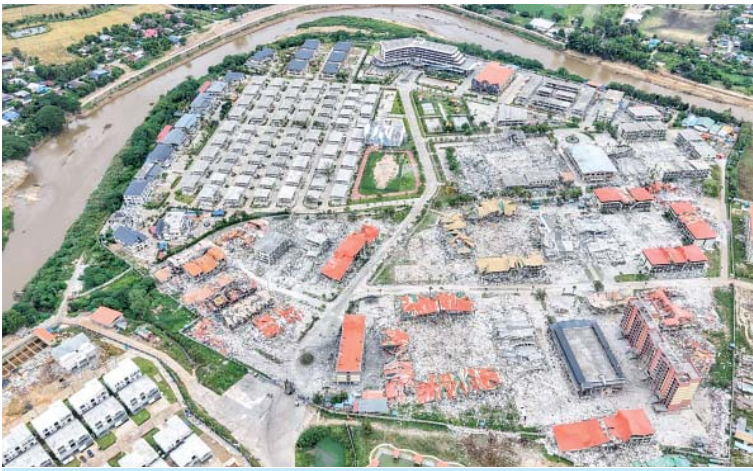
KK Park နယ်မြေအတွင်း၌ Online လိမ်လည်လောင်းကစားမှုများကျူးလွန်ရာတွင် အသုံးပြုသည့်အဆောက်အအုံများအား ဖောက်ခွဲဖျက်ဆီးထားရှိမှုကို တွေ့ရစဉ်။
