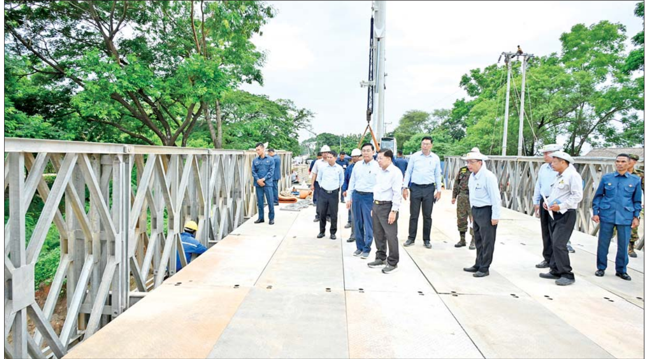
နိုင်ငံတော်စီမံအုပ်ချုပ်ရေးကောင်စီဥက္ကဋ္ဌ နိုင်ငံတော်ဝန်ကြီးချုပ် ဗိုလ်ချုပ်မှူးကြီးမင်းအောင်လှိုင် နဝင်းချောင်းတံတား(အဆို)အား ယာယီဘေးလိတ်တားထိုး၍ တည်ဆောက်ပြုပြင်နေမှုကို ကြည့်ရှုစစ်ဆေးစဉ်။
