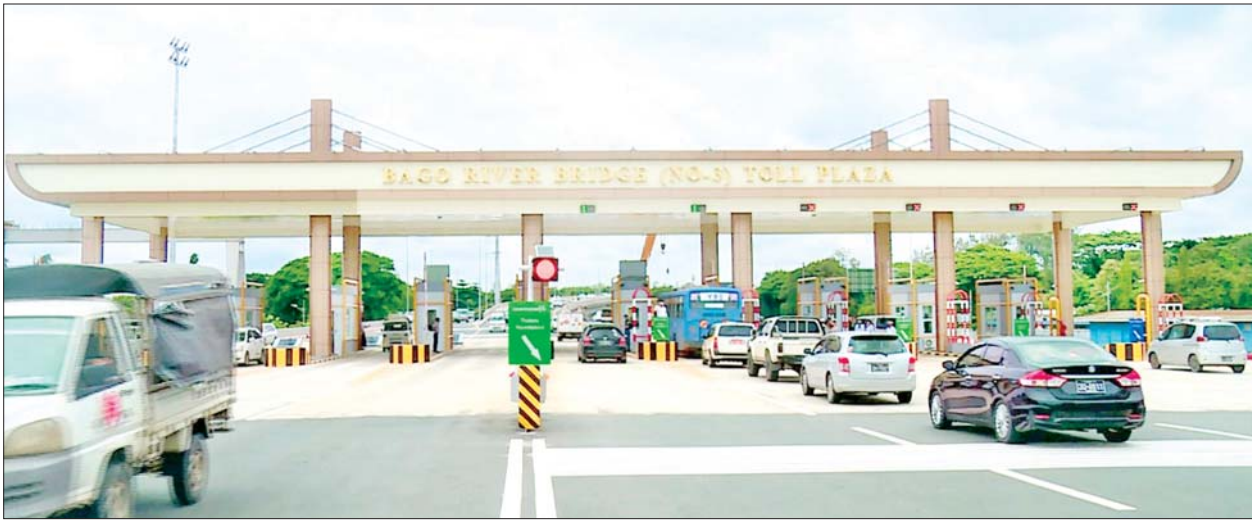
ပဲခူးမြစ်ကူးတံတား(သန်လျင်တံတားအမှတ်-၃)တံတားသစ်၏ တိုးဂိတ်(ရန်ကုန်ဘက်ခြမ်း)ကိုတွေ့ရစဉ်။ ဓာတ်ပုံ - ဇွဲမာန်
