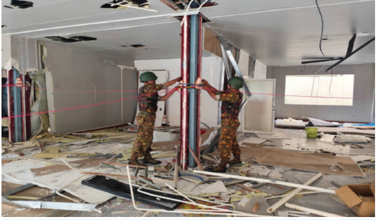
ကရင်ပြည်နယ် မြဝတီခရိုင် ရွှေကုက္ကိုလ်နယ်မြေရှိ အွန်လိုင်းလိမ်လည်လောင်းကစားမှုလုပ်ကိုင်ခဲ့သည့် တရားမဝင် ခုနစ်ထပ် လူနေအဆောက်အအုံကို ယမ်းဖြင့် ဖောက်ခွဲဖျက်ဆီးရန် ပြင်ဆင်နေစဉ်။
