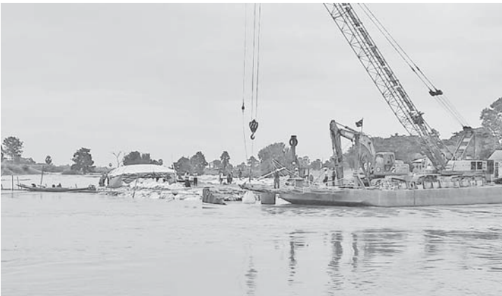
ငဝန်ပန်းတာရေဝင်ရောက်မှုကို ထိန်းချုပ်ကာကွယ်နိုင်ရန်အတွက် ငဝန်ပန်းတာတံခံခိုက်ကျနေရာများ ပြန်လည်ခိုင်မာရေးလုပ်ငန်းများဆောင်ရွက်စဉ်။
