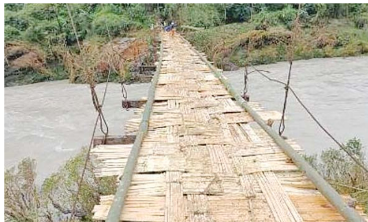
ပန်နန်းဒင်မေခမြစ်ကူး(လူကူး)ကြိုးတံတား ပြန်လည်ဆောက်လုပ်ပြီးစီးမှုကို တွေ့ရစဉ်။
