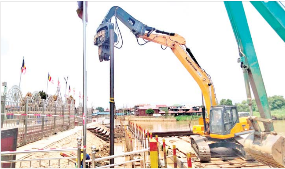
အင်းလေးဖောင်တော်ဦးမြတ်စွာဘုရား၌ Sheet Pile ရိုက်ခြင်းလုပ်ငန်း ဆောင်ရွက်နေမှုကို တွေ့ရစဉ်။
