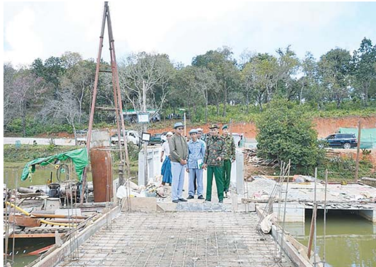
ကြိုတင်သတင်းစစ်ဌာနချုပ် တိုင်းမှူး ဗိုလ်မှူးချုပ်စိုးလှိုင် ကျိုင်းတုံမြို့နယ်၊ လွိုင်မွေကန် လူကူးသံကူကွန်ကရစ်တံတား တည်ဆောက်နေမှုကို ကြည့်ရှုစဉ်။
