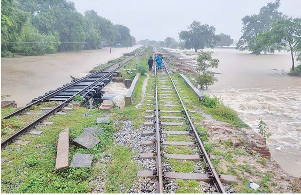
ရန်ကုန်-မန္တလေးရထားလမ်းပိုင်း ရမည်းသင်းနှင့်အင်ကြင်းကန်ဘူတာအကြား ရထားလမ်းနှင့် တံတားများ ရေတိုက်စားမှုအခြေအနေကိုတွေ့ရစဉ်။
