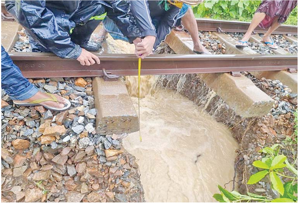
ရန်ကုန်-မန္တလေးရထားလမ်းပိုင်း ရှမ်းရွာနှင့် ပျော်ဘွယ်ဘူတာအကြား ရထားလမ်းတာပေါင်များရေတိုက်စားပြီး ထူးပေါက်မှုအခြေအနေကိုတွေ့ရစဉ်။
