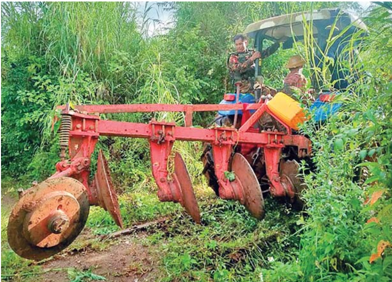
ဆမ်ဆယ်ဘူတာမှ နောင်ချိုဘူတာကြား လမ်းဘေးတောခုတ်ခြင်းဆောင်ရွက်နေမှုကို တွေ့ရစဉ်။
