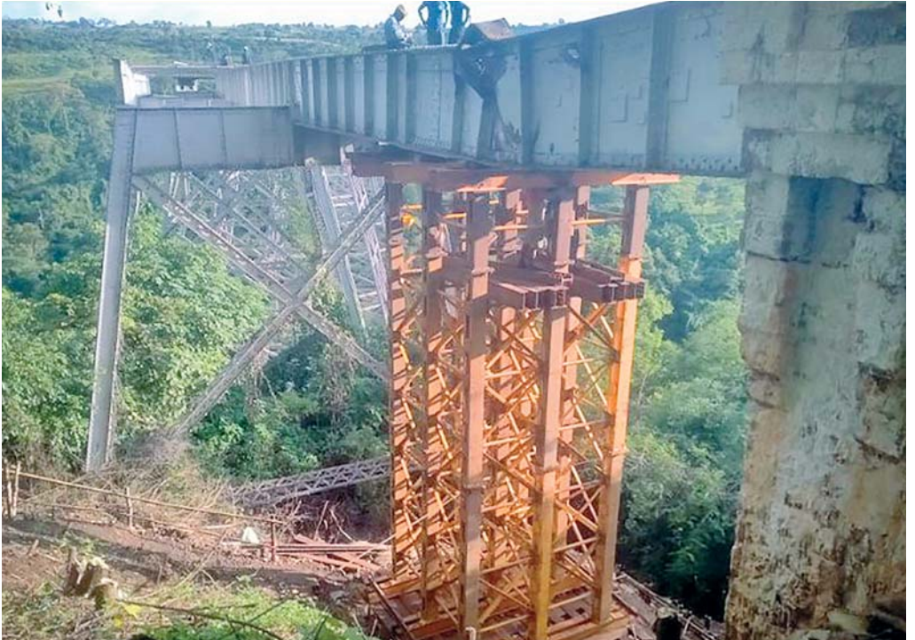
P16 နှင့် AB2 အလယ် (Mid Span)၌ L.S.T (D-Type)ပုံစံအား လိုအပ်သည့်အမြင့်အတိုင်း ထည့်သွင်းဆောင်ရွက်နေမှုကိုတွေ့ရစဉ်။
