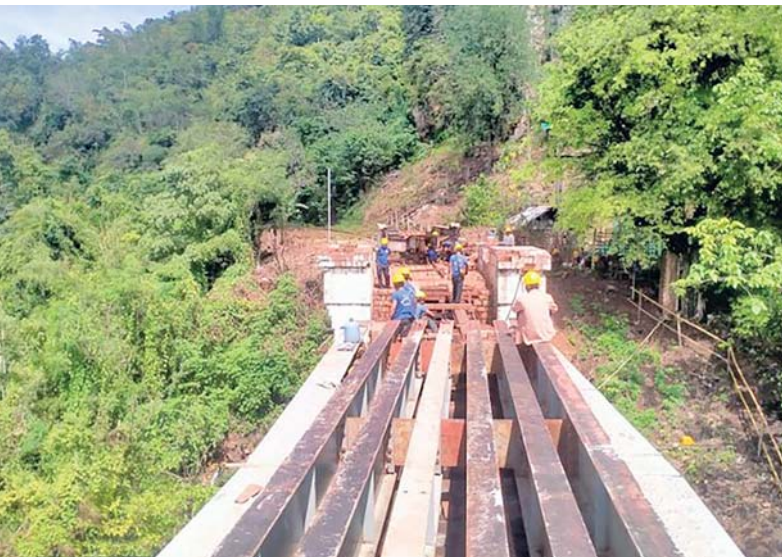
ယာယီ Way Beam သံပေါင် (၆)ချောင်းအား ထည့်သွင်းတပ်ဆင်ဆောင်ရွက်နေမှုကို တွေ့ရစဉ်။
