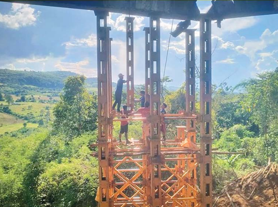
P16 နှင့် AB2 အလယ် (Mid Span)၌ L.S.T (D-Type)ပုံစံအား လိုအပ်သည့်အမြင့်အတိုင်း ထည့်သွင်းဆောင်ရွက်နေမှုကိုတွေ့ရစဉ်။
