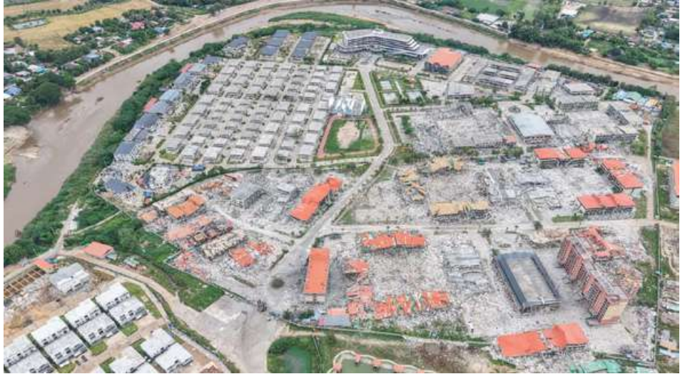
KK Park နယ်မြေအတွင်း၌ Online လိမ်လည်လောင်းကစားမှုများ ကျူးလွန်ရာတွင် အသုံးပြုသည့် အဆောက်အအုံများ ဖောက်ခွဲဖျက်ဆီးထားရှိမှုများကို တွေ့ရစဉ်။
