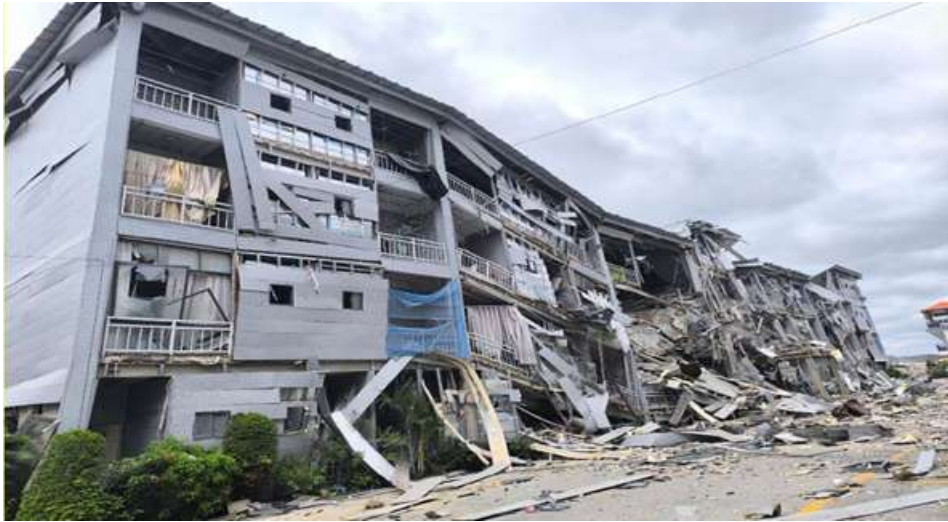
KK Park နယ်မြေအတွင်း၌ Online လိမ်လည်လောင်းကစားမှုများ ကျူးလွန်ရာတွင် အသုံးပြုသည့် အဆောက်အအုံများ ဖြိုချဖျက်ဆီးထားရှိမှုများကို တွေ့ရစဉ်။
