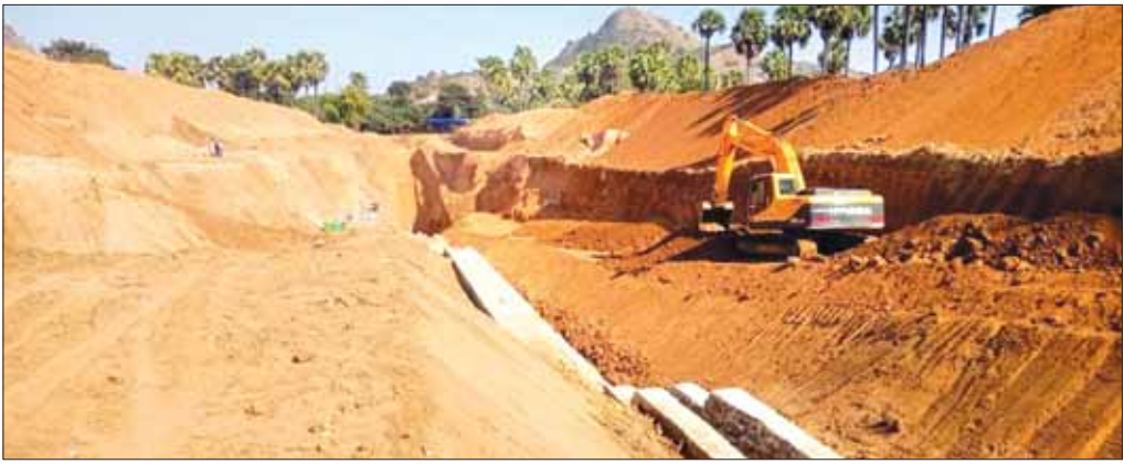
မန္တလေးတိုင်းဒေသကြီး၊ ညောင်ဦးမြို့နယ်ရှိ ကန်ကြီးကုန်းမြေအောက်တစ်တည်ဆောက်ခြင်းလုပ်ငန်းကို စက်ယန္တရားကြီးများဖြင့် ဆောင်ရွက်နေစဉ်။
