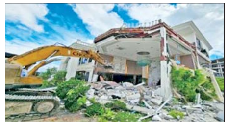
မြဝတီမြို့နယ် KK Park နယ်မြေအတွင်းရှိ ဇုန်အလိုက်မှ အဆောက်အအုံများအား ဖောက်ခွဲဖျက်ဆီးပြီးစီးမှုများကို တွေ့မြင် ရစဉ်။
