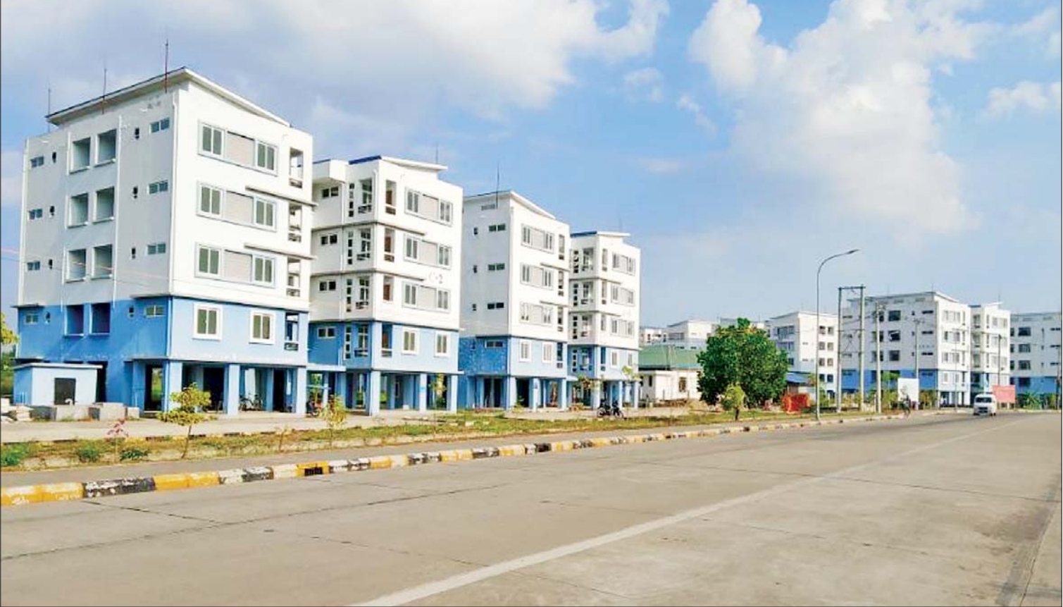
ဒဂုံမြို့သစ်(တောင်ပိုင်း)မြို့နယ်ရှိ သုခဒဂုံ ပြည်သူ့အငှားအိမ်ရာစီမံကိန်းရှိ အဆောက်အအုံများကို တွေ့ရစဉ်။
