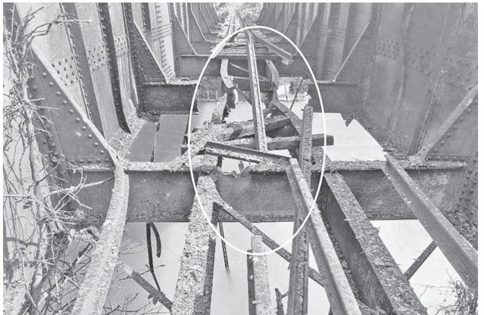
ရေး - ထားဝယ်ရထားလမ်းပိုင်းအတွင်း တနင်္သာရီတိုင်းဒေသကြီး ထားဝယ်မြို့နယ်၊ ရေဖြူနှင့် ထားဝယ်ဘူတာကြား တံတားအမှတ်(၆၀၆) မောင်မယ်ရှောင်တံတား မိုင်းခွဲဖျက်ဆီးခံထားရမှုအခြေအနေကိုတွေ့ရစဉ်။
