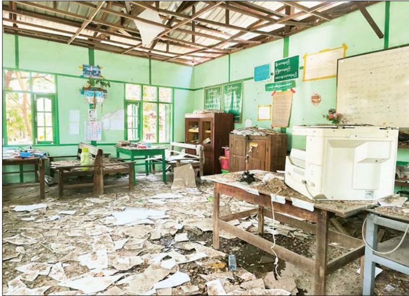
စစ်ကိုင်းတိုင်းဒေသကြီး ဒီပဲယင်းမြို့နယ် အိုးထိမ်းကွင်းကျေးရွာ၌ မေ ၁၂ ရက်တွင် လေကြောင်းဖြင့် ဖုံးကြတိုက်ခိုက်သည့်ဟု ပြည်ဖျက်မီဒီယာများက မဟုတ်မမှန် ရေးသားထုတ်လွှင့်ဖြန့်ဝေခဲ့သည့် စာသင်ကျောင်းအဆောက်အအုံနှင့် ကျောင်းအသုံးအဆောင်ပစ္စည်းများ ထိခိုက်ပျက်စီးပုံ။
