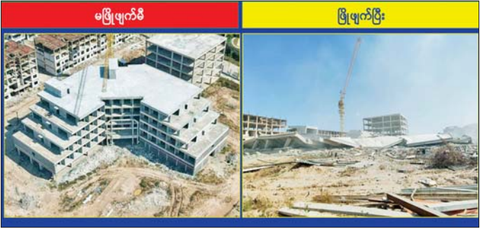
KK Park နယ်မြေ အပိုင်း (၂) တွင် တရားမဝင်ဆောက်လုပ်ထားသည့် ငါးထပ်လူနေအဆောက်အအုံများအား မဖြိုချဖျက်ဆီးနိုင် ဖြိုချဖျက်ပြီးနောက် တွေ့ရစဉ်။
