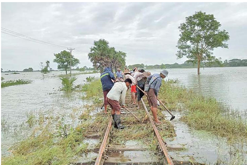
ပုသိမ်-ဟင်္သာတ-ကြိခင်းရထားလမ်းပိုင်းတွင် ရေကြီးရေလျှံမှုဖြစ်စဉ်ကြောင့် ရထားလမ်းနှင့် တံတားများ ထိခိုက်ပျက်စီးမှုများအား စစ်ဆေးပြုပြင်ခဲ့မှုအခြေအနေကိုတွေ့ရစဉ်။
