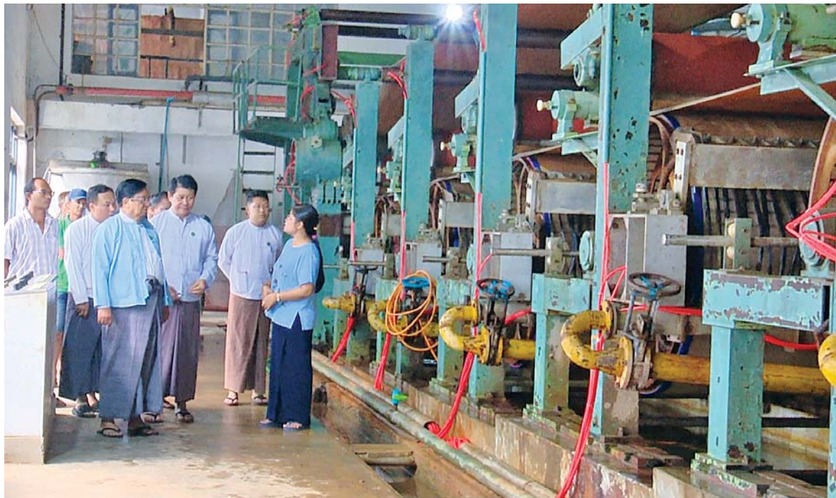
စနစ်တကျစစ်ဆေးပြီးမှသာ အသုံးပြုရန်၊ ကို သတ်မှတ်စံချိန်စံညွှန်းများနှင့်အညီ စက်ပစ္စည်းစစ်ဆေးပြုပြင်ခြင်းလုပ်ငန်းများ တိတိကျကျလိုက်နာဆောင်ရွက်ရန်၊ စက်ပစ္စည်းများကို ရေရှည်အသုံးပြုနိုင်အောင် စနစ်တကျဆောင်ရွက်ရန်၊ စက်ရုံလည်ပတ်၍ မပြတ် ဆင့်ပွားသင်တန်းများပြုလုပ်ပေးရန် မှာကြားခဲ့ကြောင်း သိရသည်။ (သတင်းစဉ်)
