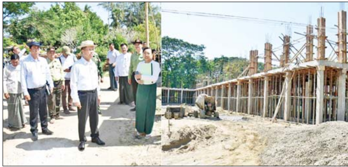
သောဒါကချောင်းကူး(နတ်ကန်)တိုင်းတည်ဆောက်ရေးလုပ်ငန်းခွင်ကို ကြည့်ရှုစစ်ဆေးပြီး စီမံကိန်းရှင်းလင်းဆောင်တွင် ကျေးလက်လမ်းဖွံ့ဖြိုးရေးဦးစီးဌာန ညွှန်ကြားရေးမှူးက လုပ်ငန်းဆောင်ရွက်မှု
