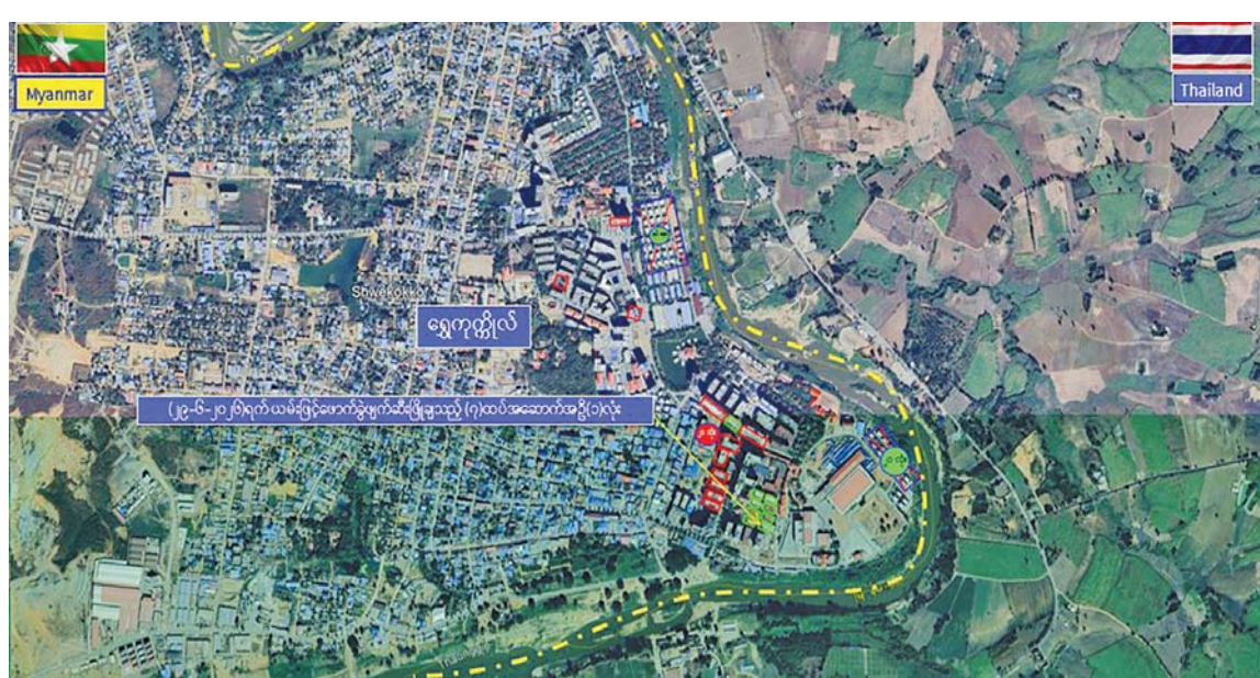
ကရင်ပြည်နယ်၊ မြဝတီမြို့နယ်၊ ရွှေကုက္ကိုလ်နယ်မြေရှိ အွန်လိုင်းလိမ်လည်လောင်းကစားမှုများလုပ်ကိုင်ခဲ့သည့် တရားမဝင်အဆောက်အအုံများအား ဖောက်ခွဲဖျက်ဆီးမှု။
