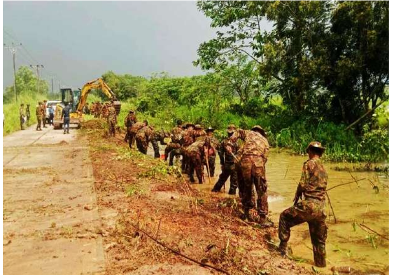
ရန်ကုန်တိုင်းဒေသကြီး လှည်းကူးမြို့နယ် ဆီဆုံကုန်းကျေးရွာ လမ်းဘေးဝဲယာတစ်လျှောက် ရေစီးရေလာကောင်းမွန်စေရေးဆောင်ရွက်စဉ်။
