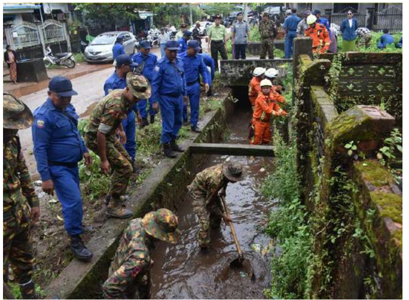
မုဒုံမြို့၌ ရေစီးရေလာကောင်းမွန်မှုရှိစေရန်ဆောင်ရွက်နေမှုကို တွေ့ရစဉ်။
