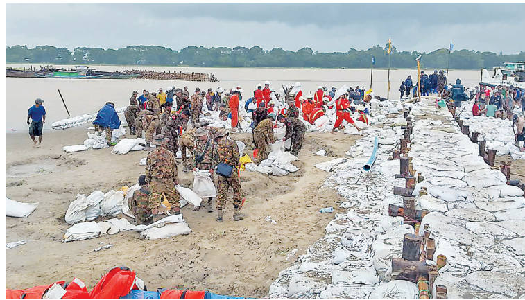
အနောက်တောင်တိုင်းစစ်ဌာနချုပ်မှ နယ်မြေခံတပ်မတော်သားများက ငဝန်ပန်းတာမှ ရေဝင်လမ်းထိန်းချုပ်ကာကွယ်နိုင်ရန်အတွက် မျောတုတ်တန်းများအတွင်း သဲအိတ်များဖြည့်၍ ကာကွယ်ခြင်းဆောင်ရွက်စဉ်။
