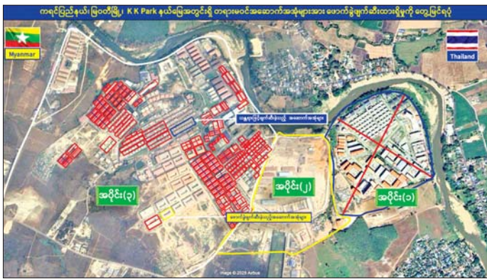
ကရင်ပြည်နယ် မြဝတီမြို့ KK Park နယ်မြေအတွင်းရှိ တရားမဝင်အဆောက်အအုံများအား ဖောက်ခွဲဖျက်ဆီးထားမှုကို တွေ့မြင်ရစဉ်။
