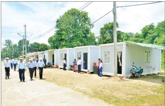
ပြည်ထောင်စုဝန်ကြီး ဦးဉာဏ်ထွန်း ငလျင်ဘေးသင့်ဝန်ထမ်းများနှင့် ဝန်ထမ်းမိသားစုများ ယာယီနေထိုင် နိုင်ရန် Container House များတွင် နေရာချထားမှု ကြည့်ရှုစစ်ဆေးစဉ်။
