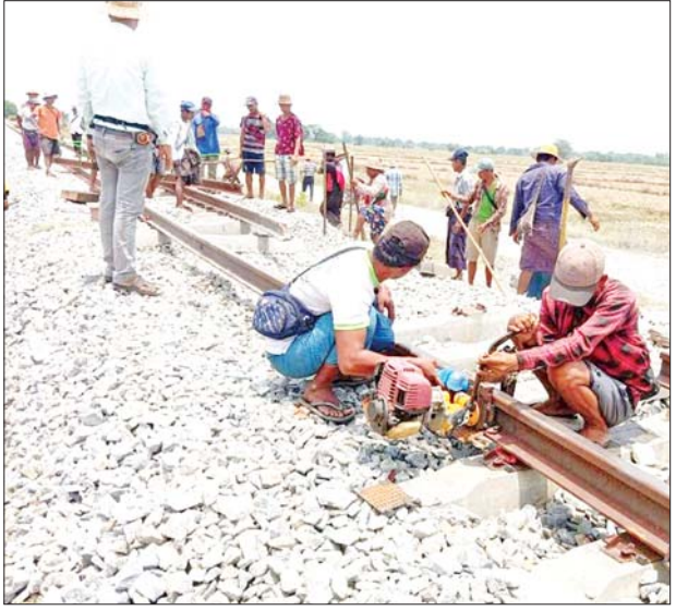
အစုန်ရထားလမ်းပေါ်၌ အကြမ်းဖက်သောင်းကျန်းသူအဖွဲ့က မိုင်းထောင်ဖောက်ခွဲဖျက်ဆီးမှုကြောင့် ရထားလမ်းပျက်စီးမှုအား ပြန်လည်ပြုပြင်ဆောင်ရွက်နေမှုကို တွေ့ရစဉ်။
