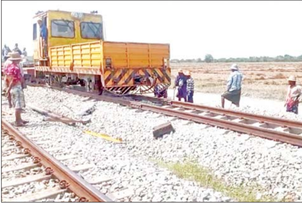
အစုန်ရထားလမ်းပေါ်၌ အကြမ်းဖက်သောင်းကျန်းသူအဖွဲ့က မိုင်းထောင်ဖောက်ခွဲဖျက်ဆီးမှုကြောင့် ရထားလမ်းပျက်စီးမှုအား ပြန်လည်ပြုပြင်ဆောင်ရွက်ပြီး RGC ဖြင့် စမ်းသပ်ဖြတ်သန်းနေမှုကို တွေ့ရစဉ်။
