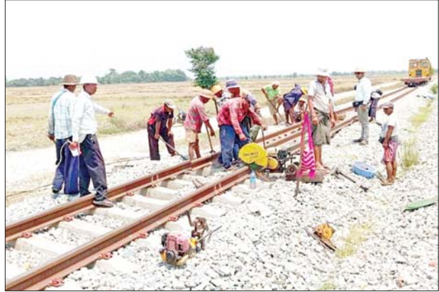
အစုန်ရထားလမ်းပေါ်၌ အကြမ်းဖက်သောင်းကျန်းသူအဖွဲ့က မိုင်းထောင်ဖောက်ခွဲဖျက်ဆီးမှုကြောင့် ရထားလမ်းပျက်စီးမှုအား ပြန်လည်ပြုပြင်ဆောင်ရွက်နေမှုကို တွေ့ရစဉ်။
