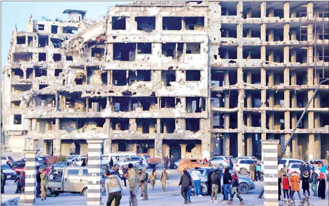
ဆီးရီးယား စစ်ပွဲအတွင်း ပျက်စီးခဲ့ရသည့် လူနေအဆောက်အအုံများကို တွေ့ရစဉ်။
