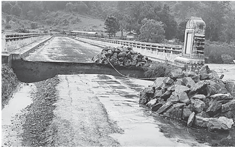
မိုင်းကိုင်-နမ့်လန်သွားလမ်းပေါ်ရှိ တံတားအမှတ်(၃/၉၁)သံကူကွန်ကရစ်တံတားရေတိုက်စားမှုကြောင့် ပြိုကျပျက်စီးမှုကိုတွေ့ရစဉ်။
