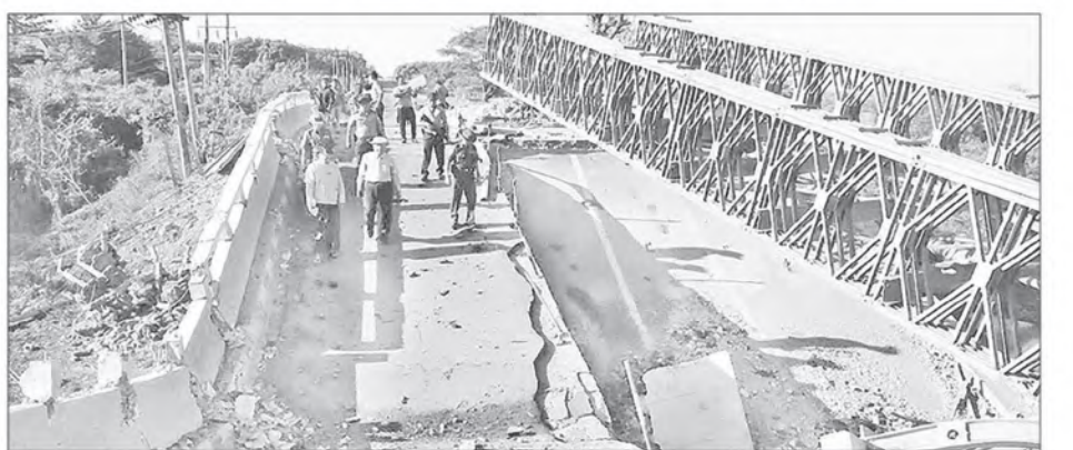
အားထားအသုံးပြုလျက်ရှိသည့် ကျိုအိတ်တံတား ၄၁ ပေ ခံနိုင်ဝန်တန် ၆၀ ရှိ သံကူကွန်ကရစ်တံတား ကို မိုင်းထောင်ဖောက်ခွဲဖျက်ဆီးခဲ့သည်။ ကျိုအိတ် တံတားသည် သထုံမြို့နယ် ရန်ကုန်-မော်လမြိုင်သွား ပြည်ထောင်စုလမ်းမပေါ်ရှိ အရှည် ၉၅ ပေအကျယ်
