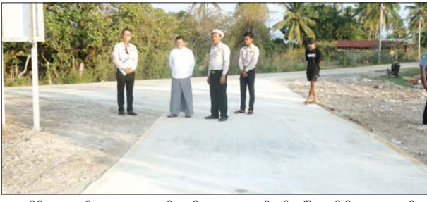
(ဝ/၃)ရိုင်း၊ အကျယ် ၁၂ ပေ၊ ၃ ခုခန့်လက်မ ကွန်ကရစ်လမ်းခင်းခြင်းနှင့် အမာခံလမ်း ပခုံးခင်းခြင်းလုပ်ငန်းကို ဘုတ်ပြင်းမြို့နယ် ကျေးလက်လမ်း ဖွံ့ဖြိုးရေးဦးစီးဌာနတာဝန်ယူ ဆောင်ရွက်လျက်ရှိပြီး လုပ်ငန်းများ ရာနန်း ပြည့် ပြီးစီးနေပြီဖြစ်သည်။ (မြို့နယ်(ပြန်/ဆက်)
