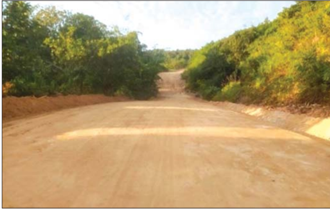
ကျွန်းစုမြို့နယ် စခန်းသစ်-ဝါးအော်ကျေးရွာချင်းဆက်လမ်း ကျောက်ရောမြေခင်းခြင်း
