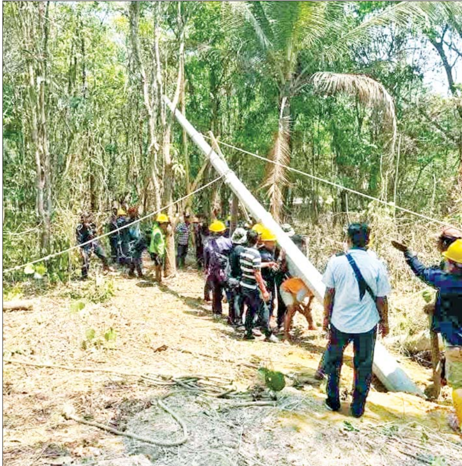
စက်ယန္တရားဝင်မရသည့်နေရာများတွင် လူအင်အားဖြင့် အပင်ပန်းခံကာ လျှပ်စစ်ဓာတ်အားလိုင်းများ ပြုပြင်ပေးစဉ်။
