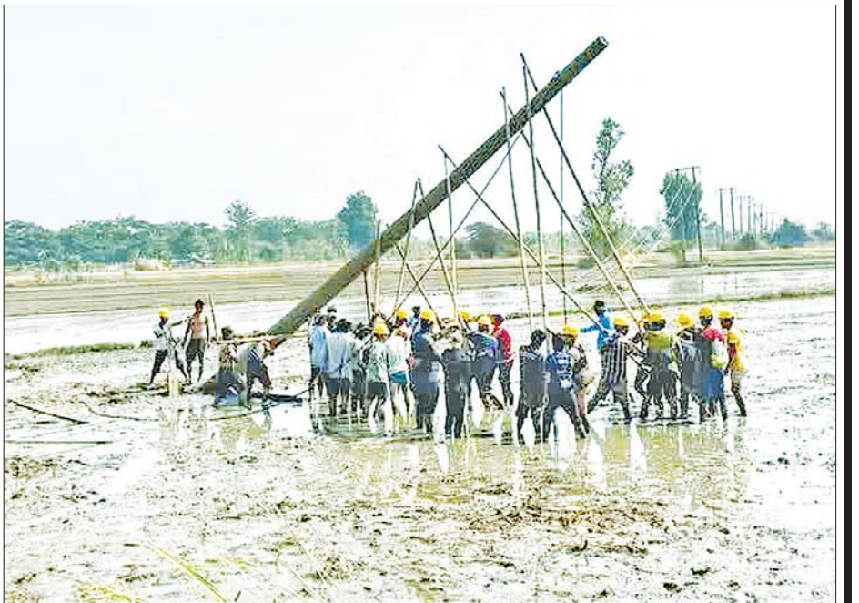
စက်ယန္တရားအကူအညီမပါဘဲ လူအင်အားဖြင့် လျှပ်စစ်ဓာတ်အားလိုင်းများ ပြုပြင်ပေးစဉ်။
