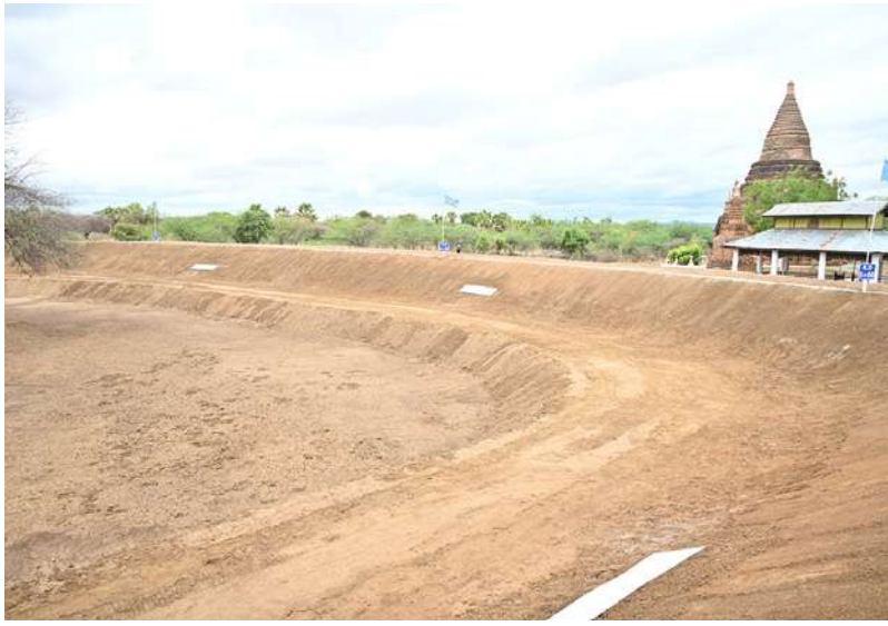
အရှေ့ဖွားစောကျေးရွာအနီးရှိ ဇေယျဝတီ(ဇေယျဝေရီ)ကန်ပြုပြင်ဆောင်ရွက်ထားမှုကို ၂၅-၅-၂၀၂၄ ရက်တွင် တွေ့ရစဉ်။
