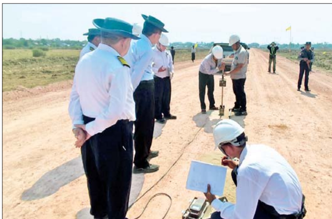
ကြား Automatic Levelling, Lining and Tamping Machine (ALLTM) စက်ကြီးများဖြင့် ကျောက်ဖြည့် ပါကင်ရိုက်ခြင်းလုပ်ငန်းများအား စနစ်တကျသေချာ စွာဆောင်ရွက်ရန်၊ ငွေ့နေရာများတွင် Alignment နှင့် Super Elevations များ မှန်ကန်မှုရှိစေရေး စနစ်တကျစစ်ဆေးသွားရန်၊ ရထားလမ်းဘေး ၀/
