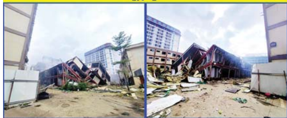
ကရင်ပြည်နယ်၊ မြဝတီခရိုင် ရွှေကုက္ကိုလ်နယ်မြေရှိ အွန်လိုင်းလိမ်လည်လောင်းကစားမှု လုပ်ကိုင်ခဲ့သည့် တရားမဝင် (၇)ထပ်လူနေအဆောက်အအုံအား ယမ်းဖြင့်ဖောက်ခွဲဖျက်ဆီးပြီး
