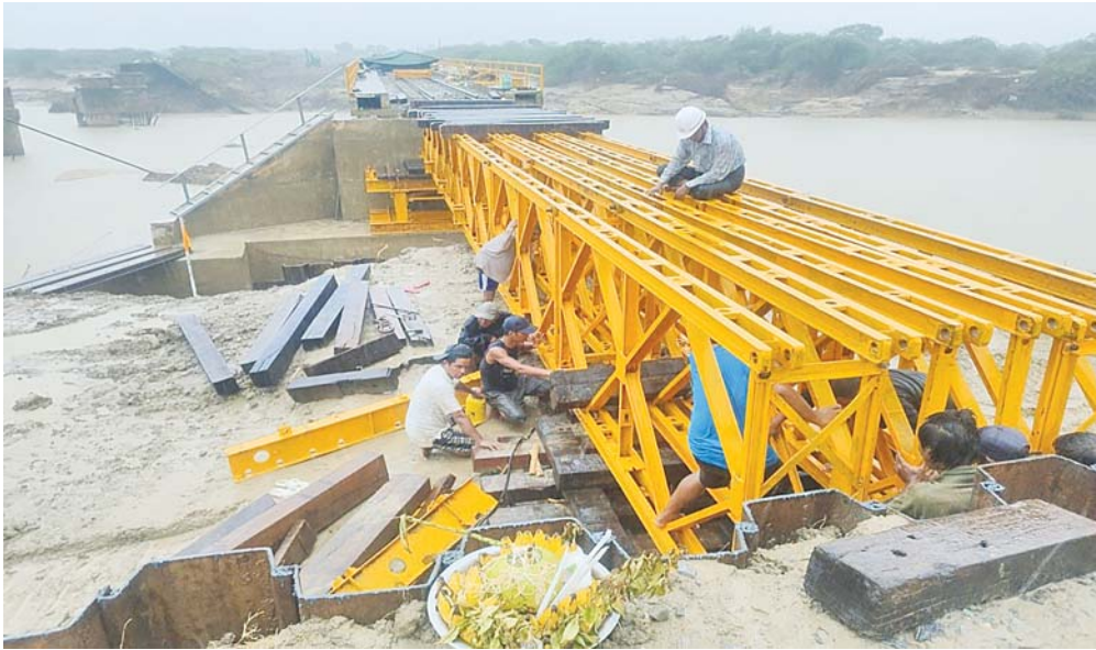
စမ့်-သပြေတောင်းကြား တံတားအမှတ် (၆၉၁)အဆန်လမ်း မန္တလေးဘက်ခြမ်း ရေတိုက်စား၍ ပျက်စီးမှုနှင့် ပြန်လည်ပြုပြင်ပြီးစီးမှုကိုတွေ့ရစဉ်။
