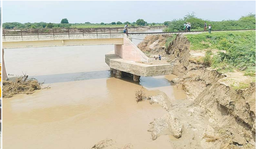
စမ့်-သပြေတောင်းကြား တံတားအမှတ် (၆၉၁)အဆန်လမ်း မန္တလေးဘက်ခြမ်း ရေတိုက်စား၍ ပျက်စီးမှုနှင့် ပြန်လည်ပြုပြင်ပြီးစီးမှုကိုတွေ့ရစဉ်။
