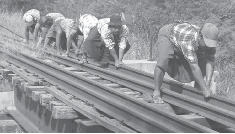
အကြမ်းဖက်သောင်းကျန်းသူအဖွဲ့၏ မိုင်းထောင်ဖောက်ခွဲမှုကြောင့် ပုဂံ-ကျောက်ပန်းတောင်းရထားလမ်းပိုင်းအတွင်း စုတည်နှင့်တောင်ဇင်း ဘူတာအကြား(မိုင်တိုင်အမှတ် ၃၈၁/၁၅-၁၆)ရှိ တံတားအမှတ် ၁၅၇ အပေါ်ရှိ ရထားသံလမ်း ပြုပြင်နေမှုကိုတွေ့ရစဉ်။
