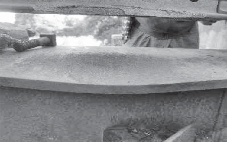
အကြမ်းဖက်သောင်းကျန်းသူအဖွဲ့၏ မိုင်းထောင်ဖောက်ခွဲမှုကြောင့် ပုဂံ-ကျောက်ပန်းတောင်းရထားလမ်းပိုင်းအတွင်း စုတည်နှင့်တောင်ဇင်း ဘူတာအကြား(မိုင်တိုင်အမှတ် ၃၈၁/၁၅-၁၆)ရှိ တံတားအမှတ် ၁၅၇ သံပေါင်ထိခိုက်ပျက်စီးမှုအခြေအနေကိုတွေ့ရစဉ်။
