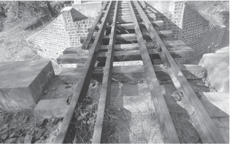
အကြမ်းဖက်သောင်းကျန်းသူအဖွဲ့၏ မိုင်းထောင်ဖောက်ခွဲမှုကြောင့် ပုဂံ-ကျောက်ပန်းတောင်းရထားလမ်းပိုင်းအတွင်း စုတည်နှင့်တောင်ဇင်း ဘူတာအကြား(မိုင်တိုင်အမှတ် ၃၈၁/၁၅-၁၆)ရှိ တံတားအမှတ် ၁၅၇ အပေါ်ရှိ ရထားသံလမ်း ပြုပြင်ပြီးစီးမှုကိုတွေ့ရစဉ်။
