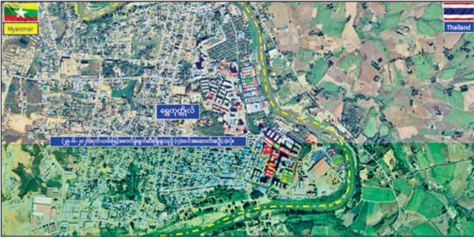
ကရင်ပြည်နယ် မြဝတီမြို့နယ် ရွှေကုက္ကိုလ်နယ်မြေရှိ အွန်လိုင်းလိမ်လည် လောင်းကစားမှုများ လုပ်ကိုင်ခဲ့သည့် တရားမဝင် အဆောက်အအုံများအား ဖောက်ခွဲဖျက်ဆီးမှုကို တွေ့ရစဉ်။
