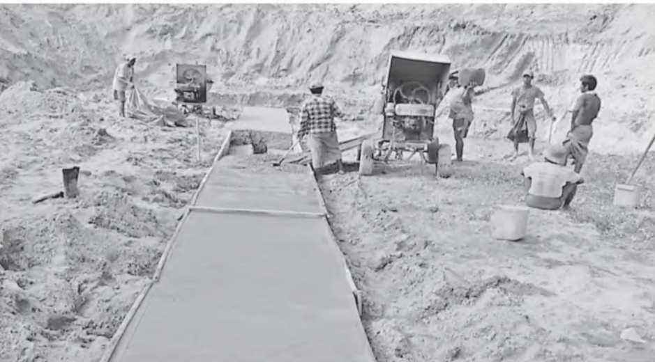
မကွေးတိုင်းဒေသကြီး ဆင်ပေါင်ဝဲမြို့နယ်အတွင်း လင်ပန်းချောင်းမြေအောက်တပ်ဆင်ဆောင်ရွက်ခြင်းလုပ်ငန်း ဆောင်ရွက်နေမှုကို တွေ့ရစဉ်။
