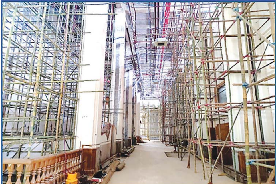
နံရံနှင့်မျက်နှာကြက်များ ပြုပြင်ဆောင်ရွက်နေမှု
