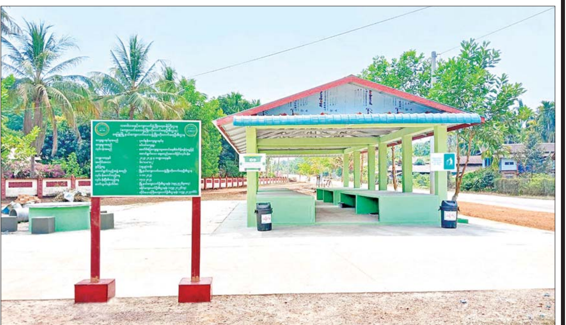
ရေဖြူမြို့နယ် မင်းဒပ်ကျေးရွာ၌ ကျေးရွာဈေးတည်ဆောက်ထားမှုကို တွေ့ရစဉ်။
