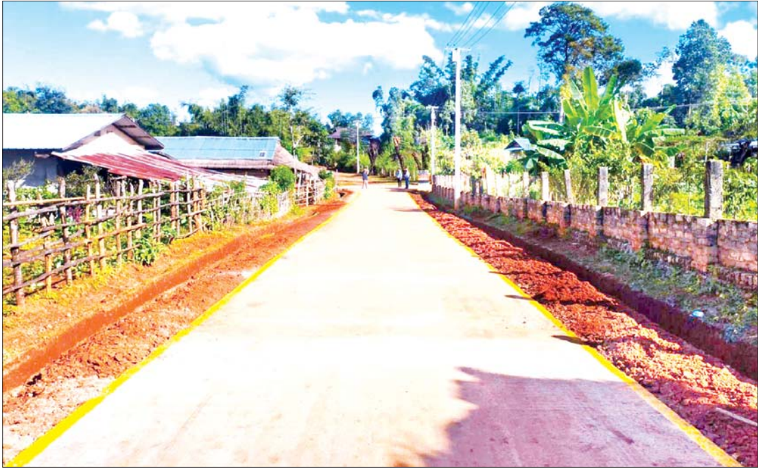
တန့်ယန်းမြို့နယ် နန့်ဟူးလွယ်ကာကျေးရွာအတွင်း ကွန်ကရစ်လမ်းခင်းထားမှုကို တွေ့ရစဉ်။
