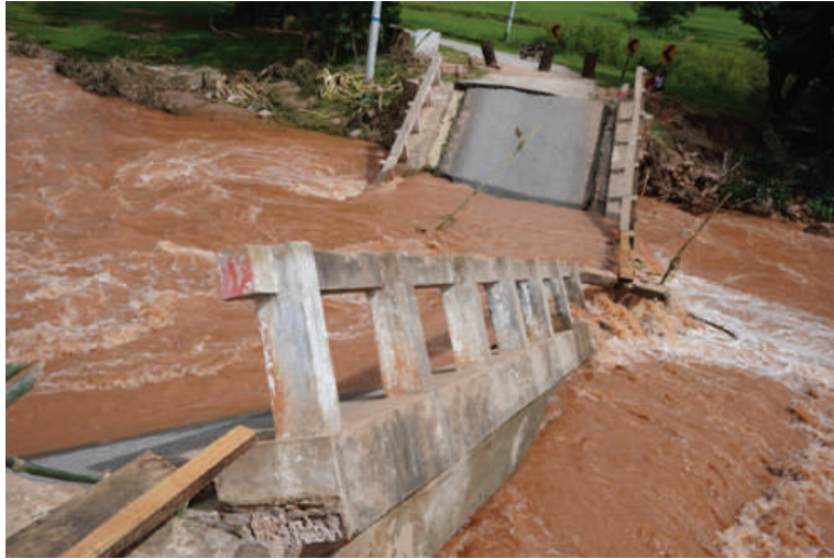
တောင်ကျချောင်းရေမြင့်တက်မှုကြောင့် ပြိုကျပျက်စီးခဲ့သည့် နမ့်လပ်ချောင်းကူး တံတားကို တွေ့ရစဉ်။
