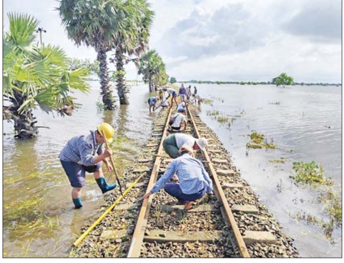
ပုသိမ်-ဟင်္သာတ-ကြာခင်းရထားလမ်းပိုင်းအတွင်း ရေကြီး၊ ရေလျှံမှုဖြစ်စဉ်ကြောင့် ရထားလမ်းနှင့် တံတားများ ထိခိုက်ပျက်စီးမှုများကို စစ်ဆေးပြုပြင်ခဲ့မှုအခြေအနေကို တွေ့ရစဉ်။
