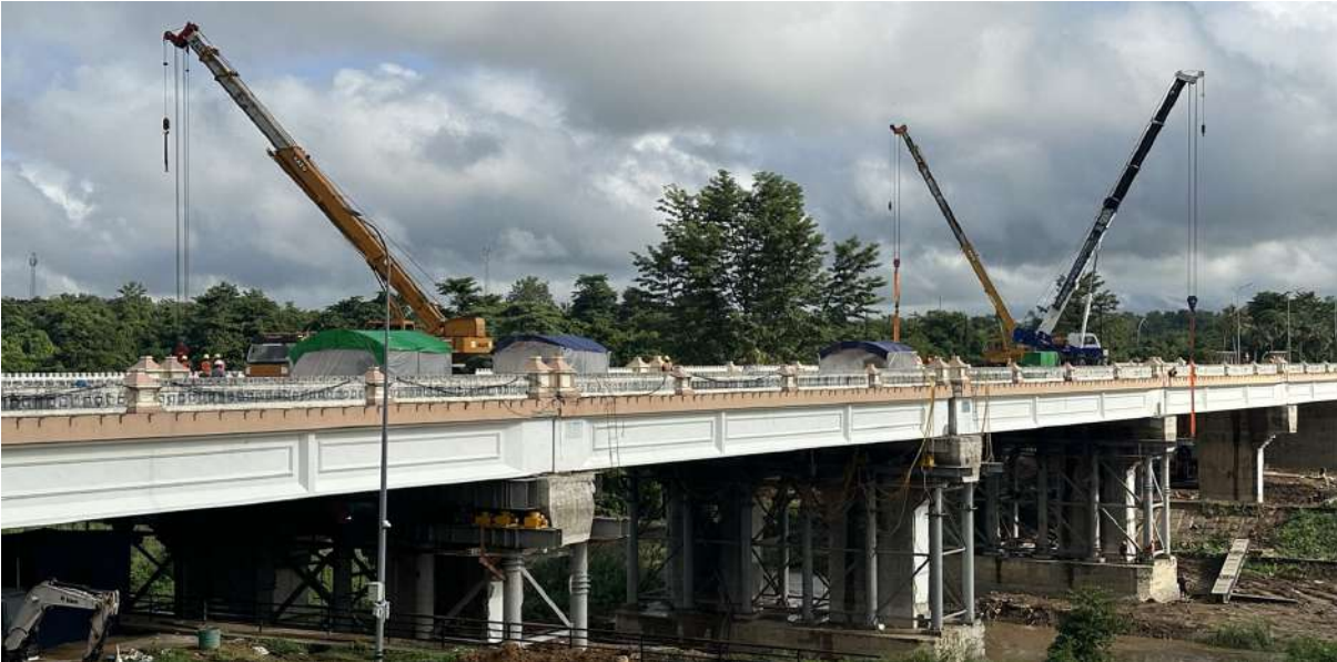
ငလျင်ဒဏ်ကြောင့် ထိခိုက်ပျက်စီးခဲ့သည့် လွှတ်တော်အဝင် အမှတ်(၁) တံတားအား ခေတ်မီနည်းပညာများဖြင့် ပြုပြင်ဆောင်ရွက်နေမှုကို တွေ့ရစဉ်။
