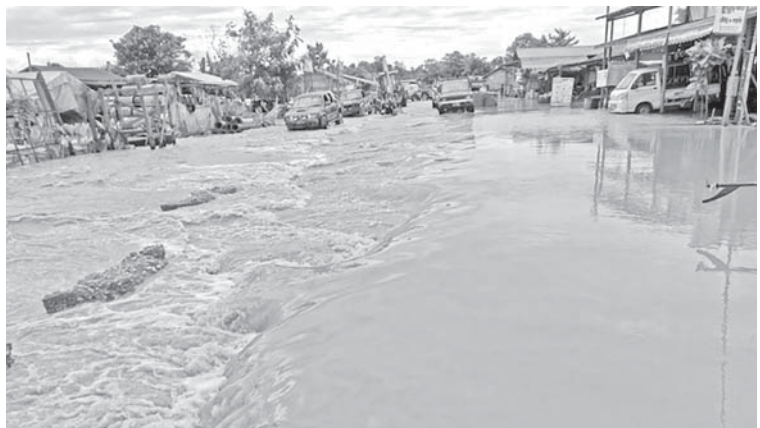
သတ္တယံကျင်း-ဖောင်းပြင်-ဟုမ္မလင်း-ခန္တီးလမ်းပိုင်းတွင် ကားလမ်းရေကျော်နေမှုကို တွေ့ရစဉ်။
