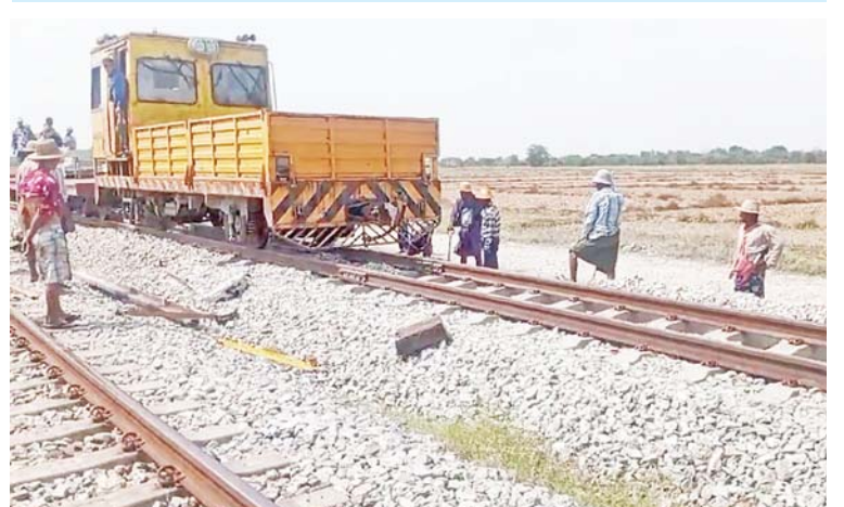
အစုန်ရထားလမ်းပေါ်၌ အကြမ်းဖက်သောင်းကျန်းသူအဖွဲ့က မိုင်းထောင်ဖောက်ခွဲဖျက်ဆီးမှုကြောင့် ရထားလမ်းပျက်စီးမှုအား ပြန်လည်ပြုပြင်ဆောင်ရွက်ပြီး RGC ဖြင့် စမ်းသပ်ဖြတ်သန်းနေမှုကိုတွေ့ရစဉ်။
