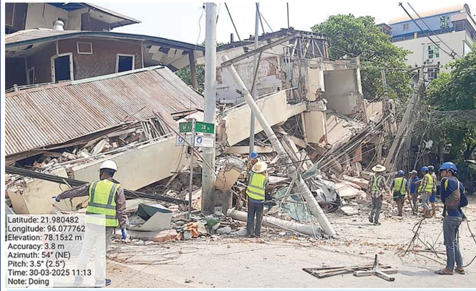
ငလျင်ဒဏ်ကြောင့်ချွတ်ယွင်းပျက်စီးသွားသော တယ်လီဖုန်းတိုင်များနှင့် ဖိုက်ဘာကေဘယ်ကြိုးများအား ပြန်လည်ပြုပြင်ခြင်းလုပ်ငန်းဆောင်ရွက်စဉ်။
